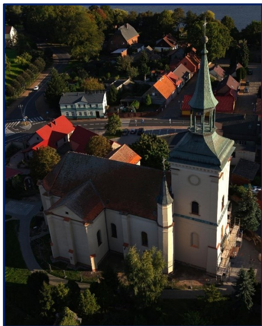
Nowa elewacja kościoła parafialnego w Osiecznej
