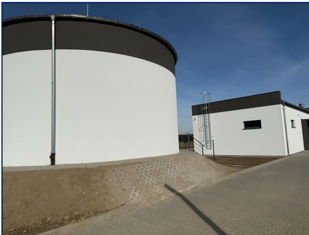
Stacja Uzdatniania Wody we Frankowie
