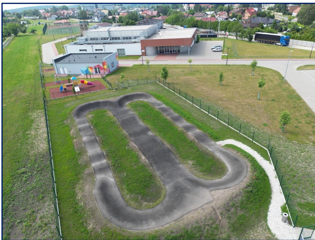
Pumprack w Osiecznej
