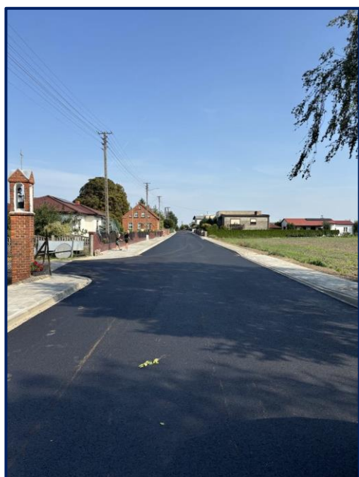
Remont drogi asfaltowej w m. Grodzisko
